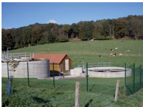
Station d'épuration d'Anquetierville
