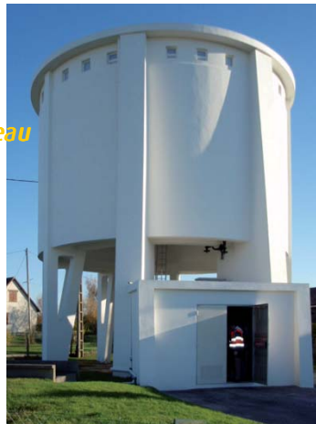
Reservoir et local Jumièges
