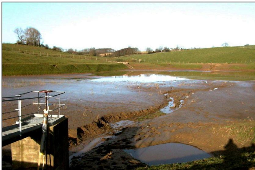
**Photo n° 8** : Un ouvrage non entretenu peut s'envaser très rapidement et perdre ses capacités de stockage : les vases sont remises en suspension et relarguées provoquant une ravine
