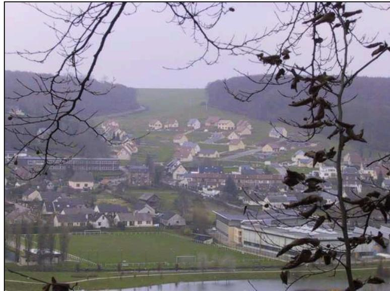
**Photo n° 3 :** Le lotissement est placé dans un talweg (l'espace en herbe entre deux zones boisées). Une bande non construite maintenue en herbe et ne contenant pas de voirie a été maintenue pour laisser passer les eaux de ruissellement du plateau. Elle correspond à l'axe du talweg. La voirie n'est pas sur l'axe de ruissellement.
