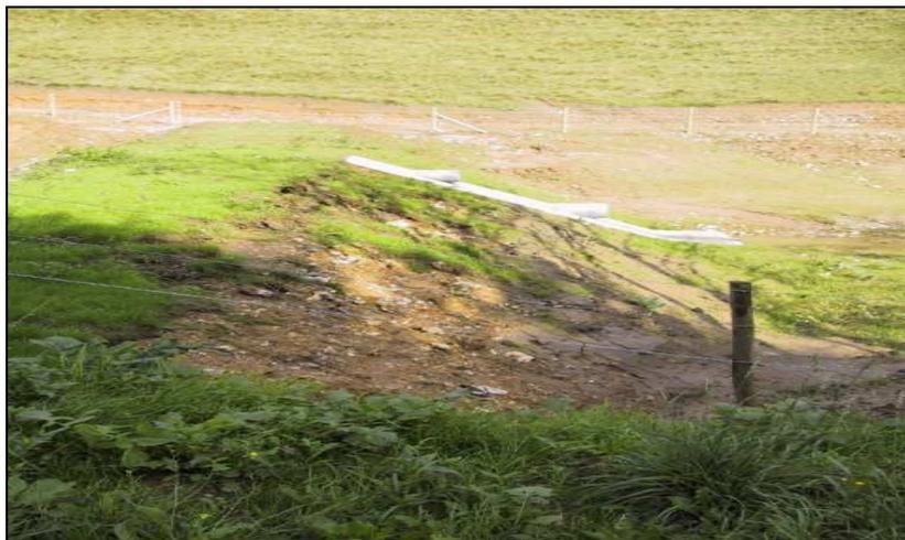
**Photo n° 9** : Un ouvrage dont les arrivées ne sont pas protégées ou dont la digue n'est pas protégée en cas de débordement, peut se dégrader très rapidement.
