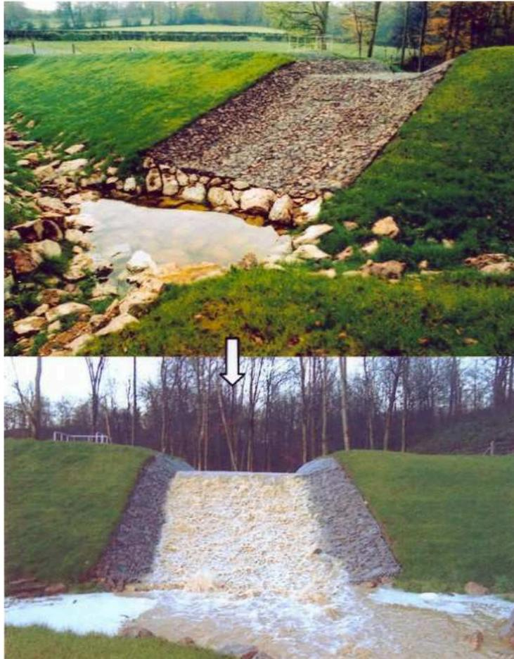
**Photo n° 7 :** Surverse d'un ouvrage (matelas Gabion) ; en haut à sec et en bas en charge hydraulique
